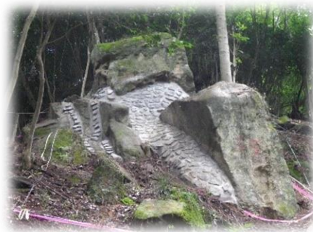
岩石着DKボンド工法の施工完了
