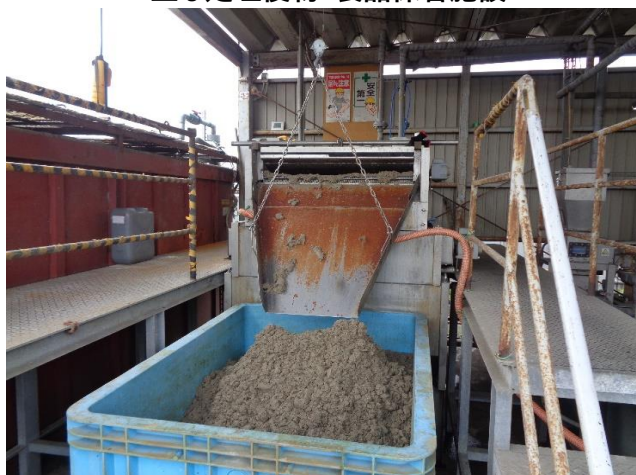
主な処理後物・製品保管施設
