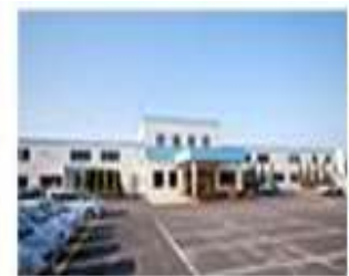
築館工場 200KW
