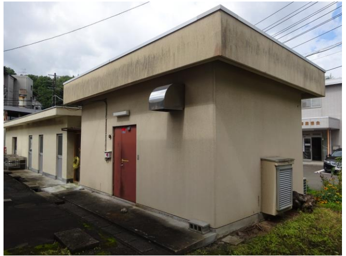
1 6 保冷保管施設
