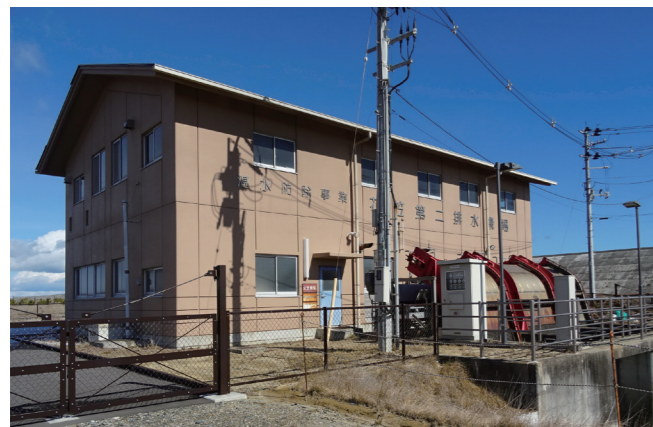
復旧後の花笠第2排水機場（令和3年2月）
