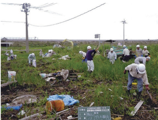
農地のがれき撤去作業の様子（巨理町）（平成23年10月）
