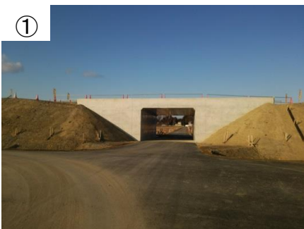
5号函渠施工状況
