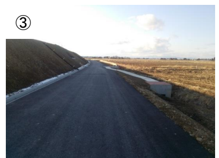
側道部の施工状況
