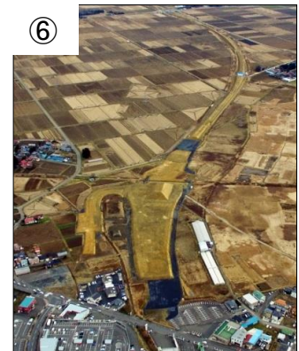
(仮)佐沼IC付近の盛土状況
