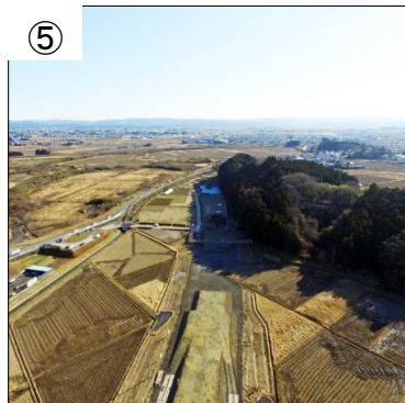
国道398号付近の盛土状況
