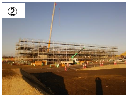
(仮称)中田IC 橋梁上部工施工状況
