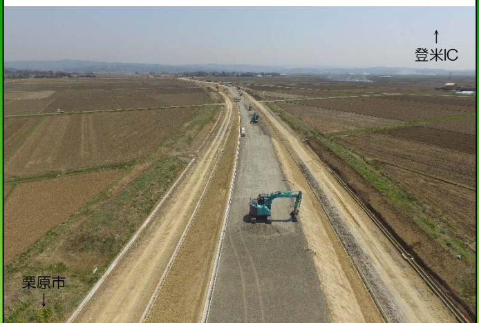
③ 石森地区2 路盤工と排水工を施工しています。
