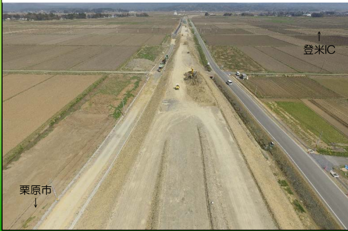
⑤ 宝江地区 盛土区間の整形を行っています。
