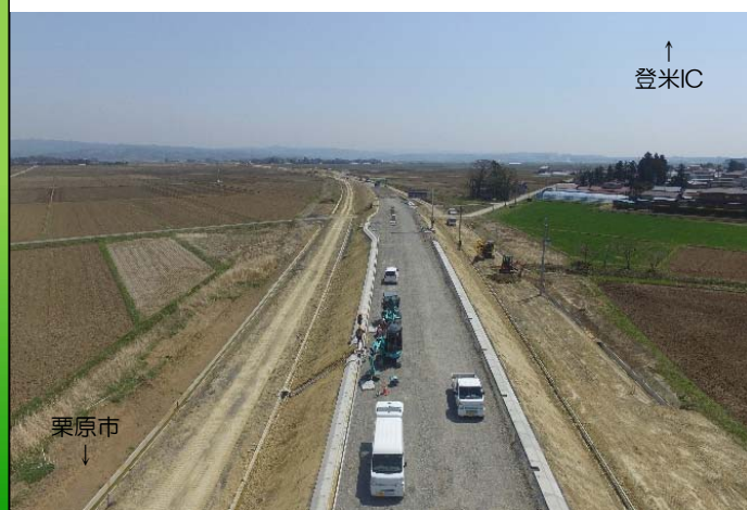
② 石森地区 路盤工が完了し、舗装工に着手します。
