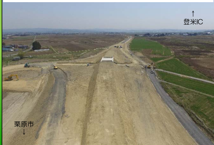
① 佐沼IC 載荷盛土が完了し、路盤工に着手します。
