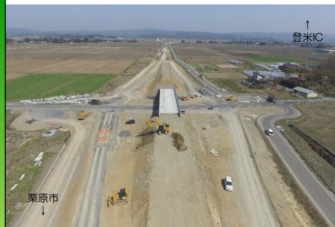
④ 中田IC インターチェンジ部の整形を行っています。
