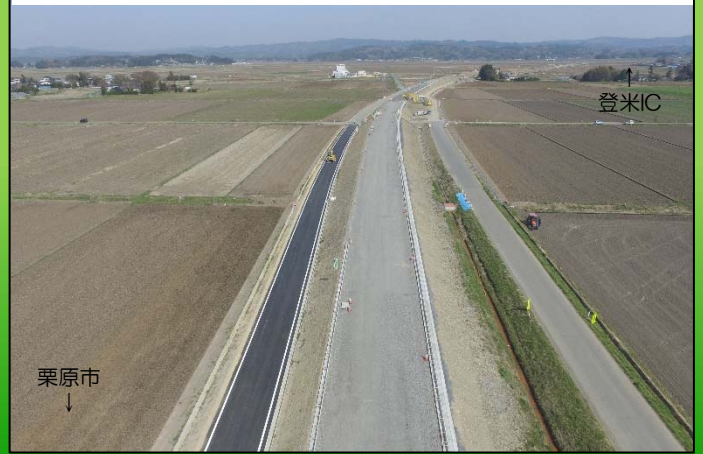
⑥ 宝江地区2 路盤工、側道が完了しました。
