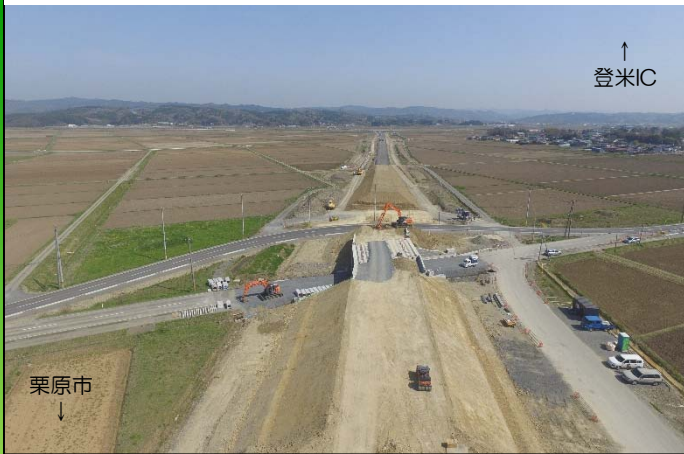
⑦ 宝江地区3 県道を本線に切り換える工事をしています。
