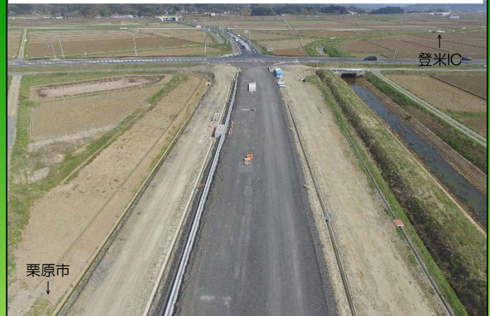
⑧ 登米IC 路盤工、排水工を施工しています。
