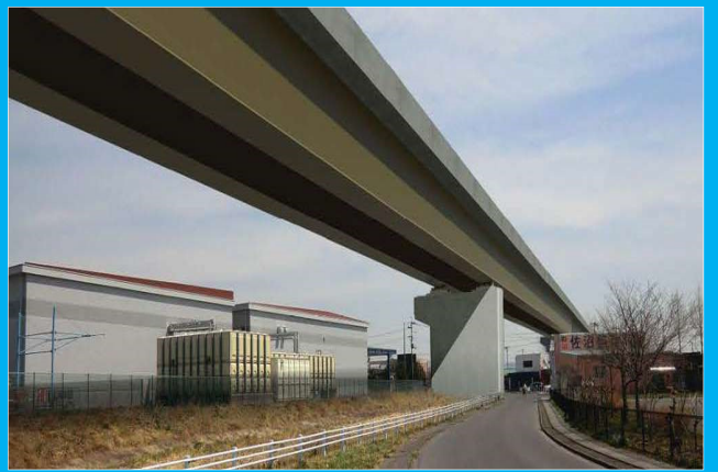
加賀野高架橋
