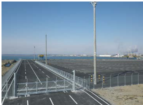
② 雲雀野中央埠頭荷捌地：嵩上げ
