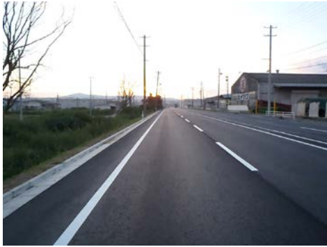
① 釜北線：舗装修繕
