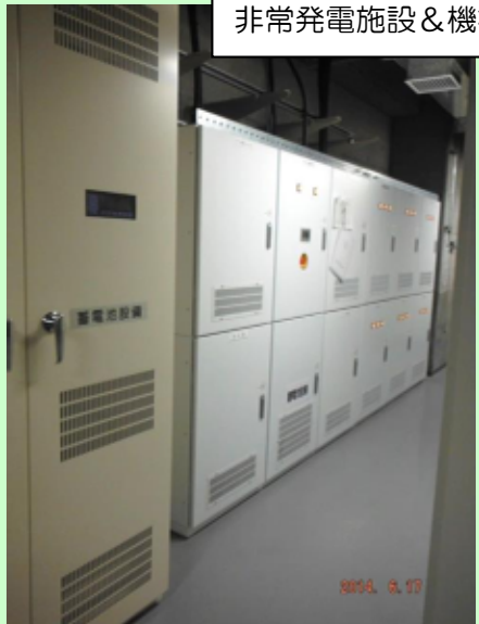
非常発電施設&機械室
