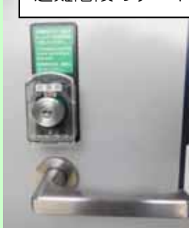
避難階段のゲート
