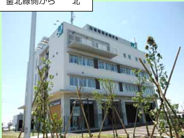
釜中線側から 南
