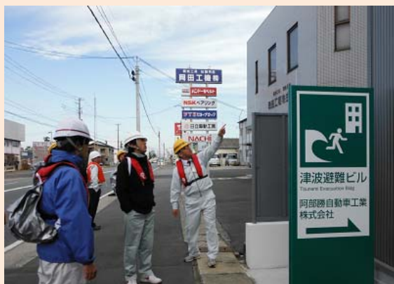
避難経路の途中にある津波避難ビル
