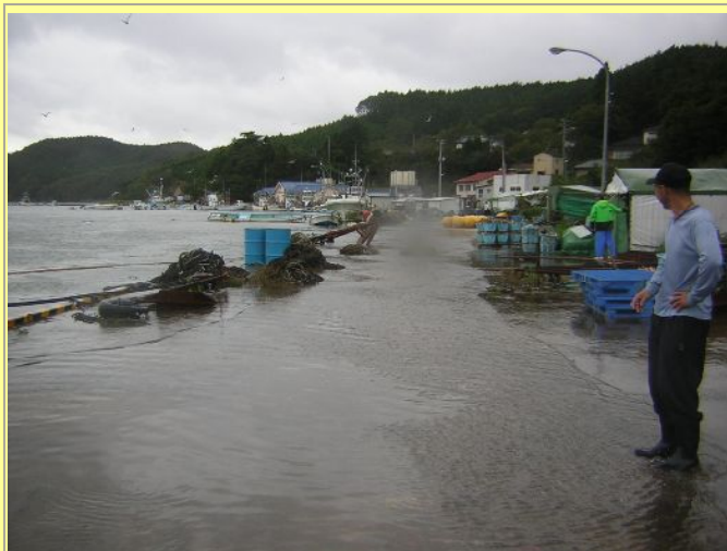
10/7 荻浜港(荷捌地浸水)
