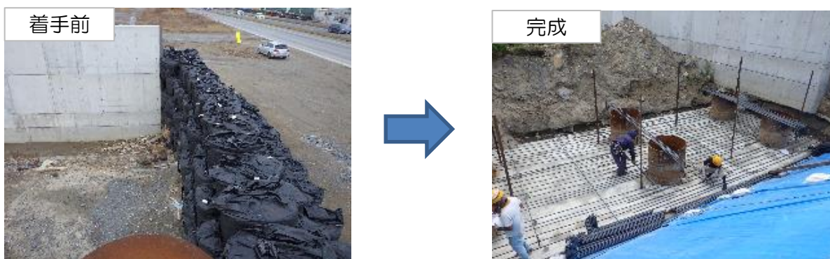
陸閘下部工事(雲雀野工区) 施工延長 L=11.8m
