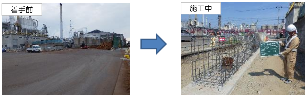
防潮堤工事(潮見工区) 施工延長 L=30.4m
