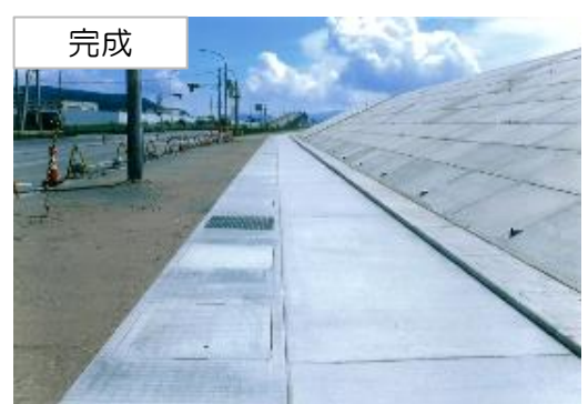
② 東浜防潮堤災害復旧工事(その5) 施工延長 L=561.5m
