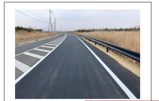
舗装の打替え
