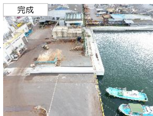
② 防潮堤工事(潮見工区) 施工延長 L=30.4m
