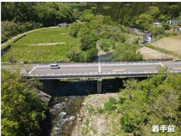
橋梁耐震補強事業 (古関橋 橋脚巻立て)
