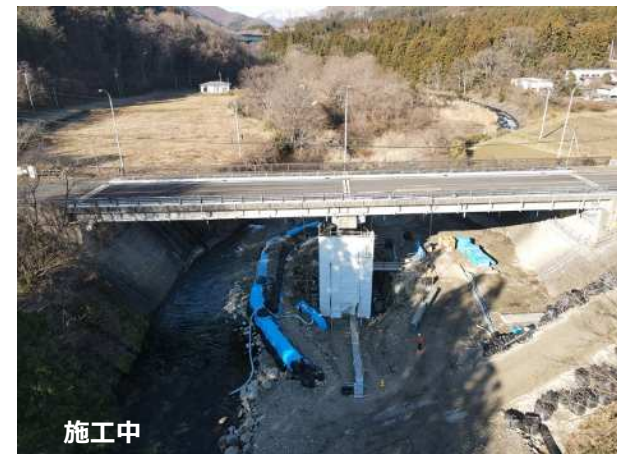
橋梁耐震補強事業 (古関橋 橋脚巻立て)
