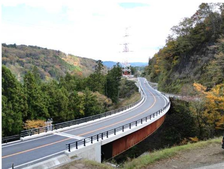
(国) 113号 福岡蔵本道路改良工事 (R7完成)
