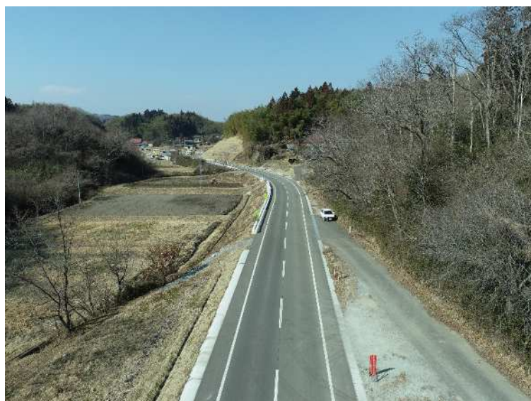
(主) 白石丸森線 大張館矢間道路改良工事
