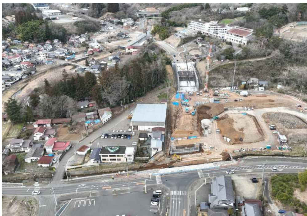
(都) 小池石生線 街路事業 (終点側 R8.3施工中)
