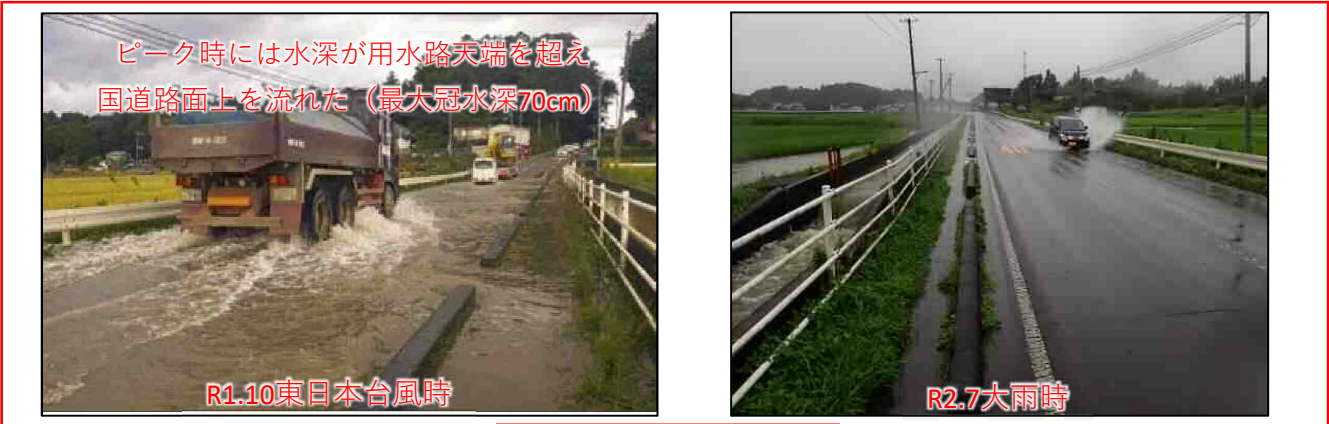
▲整備前現道冠水状況
