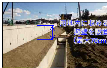
▲擁壁（ガードレール基礎）設置状況
