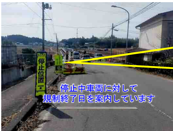
▲白石側交通規制状況
