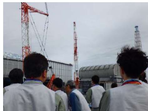
図5-6 東京電力福島第一原子力発電所 現地調査（令和6年6月6日）
