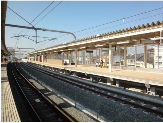
新下り線ホームの状況
