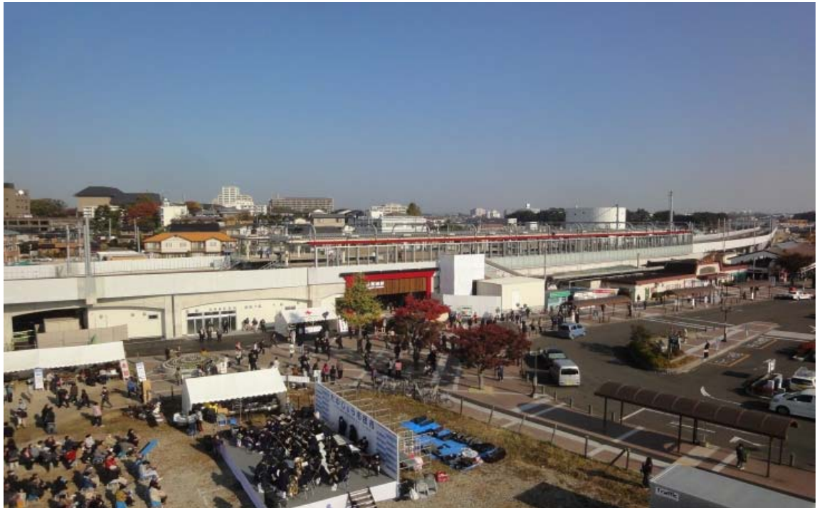
多賀城駅南口側からの状況
