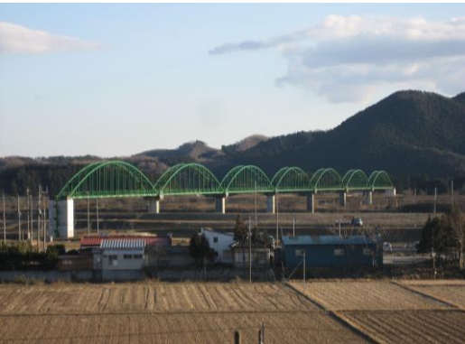
< 阿武隈川水管橋 >
