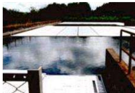
浮揚型の天蓋による部分遮光
