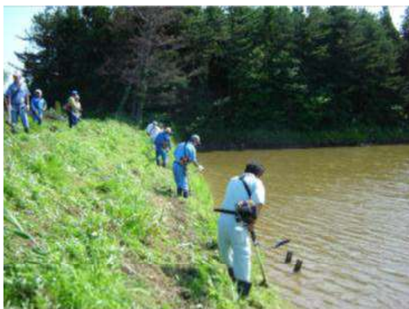
ため池堤体の草刈り
