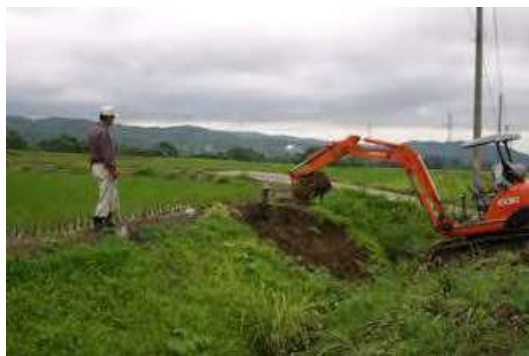
農用地法面の補修
