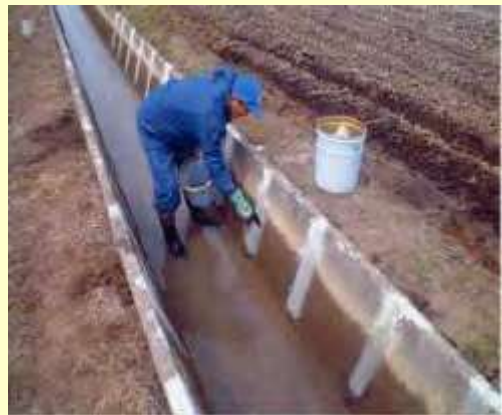
目地詰め作業
