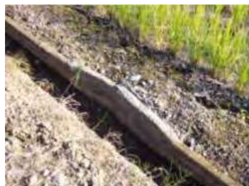
改修したU字溝
