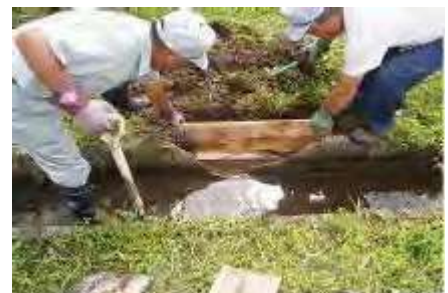
U字溝の改修作業
