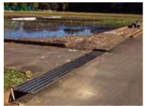
コンクリート蓋とグレーチング
