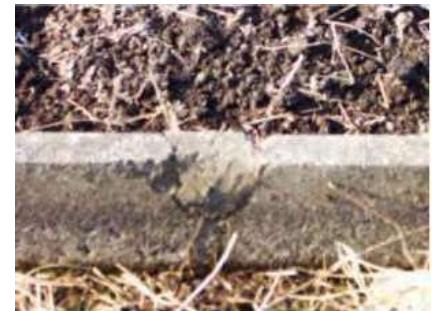
欠損箇所の補修（側溝） （モルタルによる補修）
