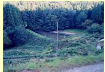
改修前のため池の様子
