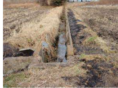
老朽化した水路（全景）
