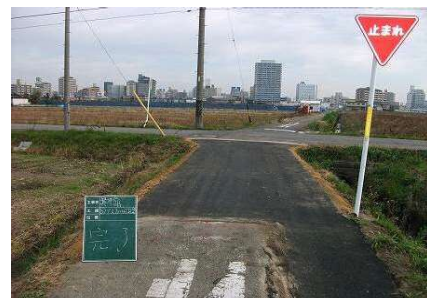
アスファルト舗装の打換え
