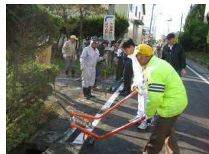
水路蓋の設置 (専用器具使用)
