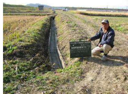
土側溝をコンクリート側溝に更新
