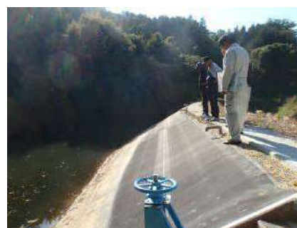
遮水シートの設置
