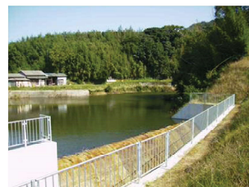
金網フェンスの 設置状況
