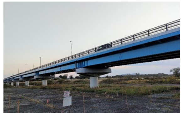
上部工架け替え後
