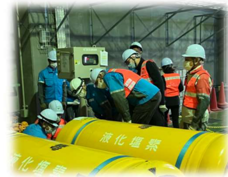
安全衛生パトロール
