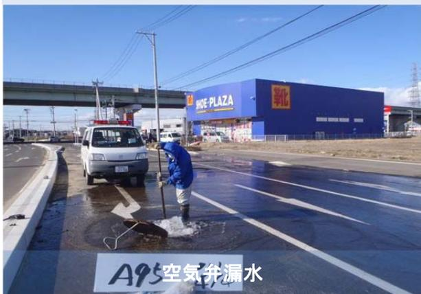
A95 空気弁漏水
