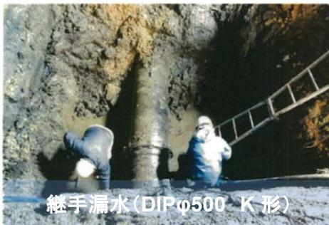
継手漏水(DIPφ500 K形)
