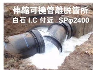
（送水施設で10か所の漏水発生、高区調整池、低区調整池、制御室では緊急遮断弁を全閉、全区間で送水停止状態）
