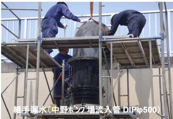
継手漏水(中野ポンプ場流入管 DIPφ500)
