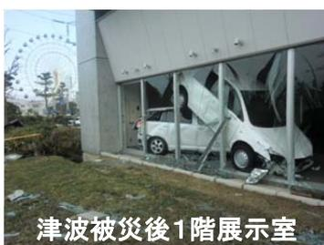
その後、3月17日に、応急危険度判定を実施し、構造体には問題がないことが確認されたものの、津波により漂着した自動車等により1階部分のガラス壁が突き破られたため、施設保全のため、仮囲い工事を行った（3月22日着手、3月29日竣工）。
