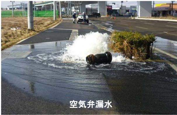
空気弁漏水
