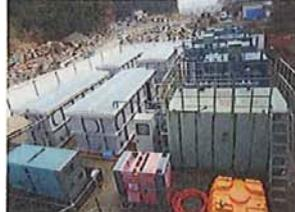
処理ユニットによる処理場と別位置での応急対応状況(陸前高田市)
