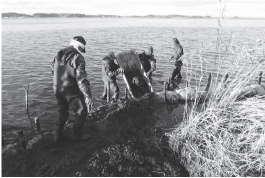
▲エコトーン造成作業の様子
