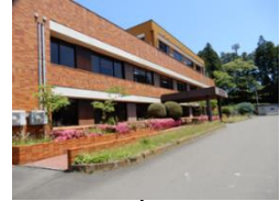
⑧多賀城分庁舎
