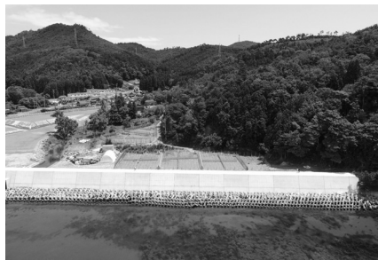
写真－7 復旧した防潮堤（石巻市十八成浜）
