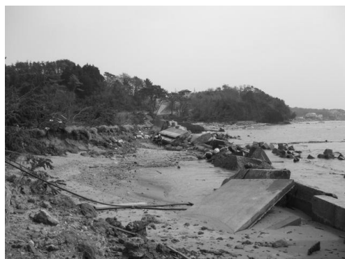
写真-3 海岸防潮堤の被害
