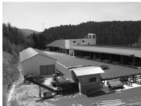
写真－9 復旧した製材工場（南三陸町）
