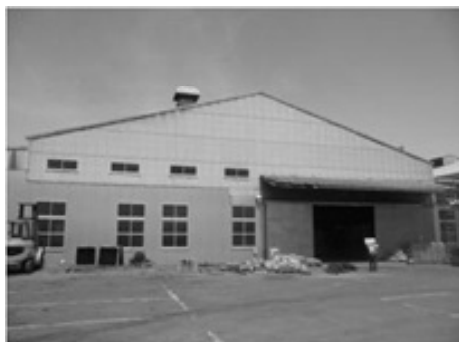
写真－8 復旧した合板工場（石巻市）
