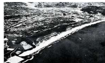
着工前の石巻港区
