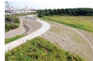
仙台塩釜港仙台港区 (向洋地区防潮堤)
