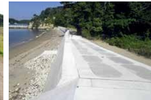
仙台塩釜港塩釜港区 (寒風沢防潮堤)
