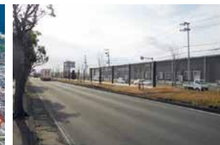
津波漂流物対策施設 (設置状況)
