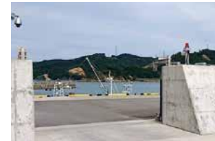
仙台塩釜港塩釜港区
