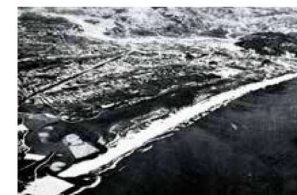
着工前の石巻港区
