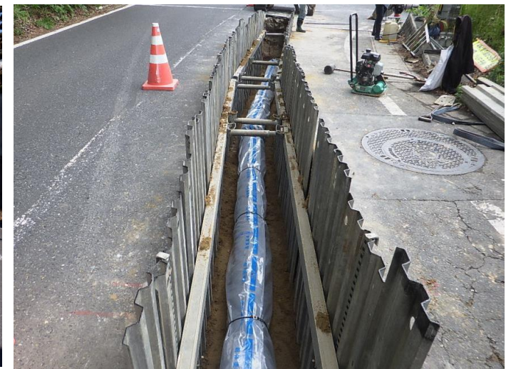
管路埋設状況
