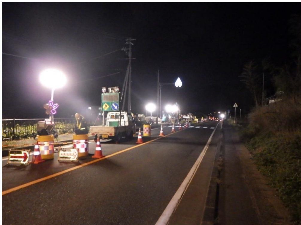
国道4号を通行規制しての作業状況
