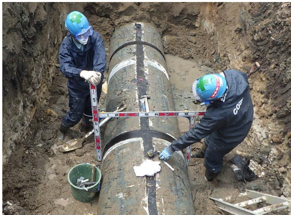
既設工業用水道管の埋設状況の確認
