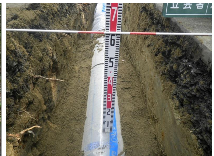
管路埋設状況
