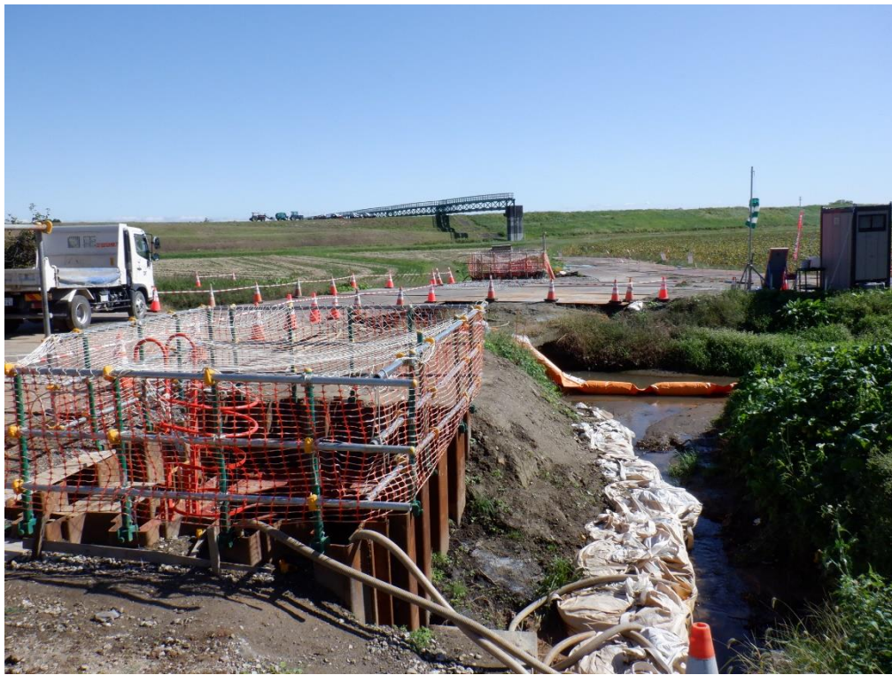
推進工の施工状況(西側から東側を望む)
