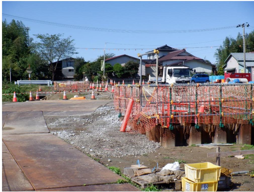
推進工の施工状況(東側から西側を望む)
