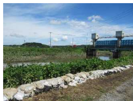
出来川右岸（名鱈地先） 土のう積み
