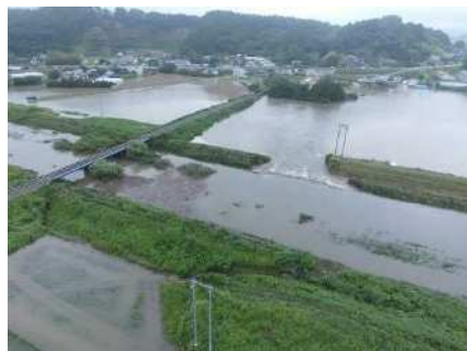
出来川右岸（名鱈地先） 破堤箇所
