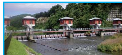
基幹水利施設管理事業 伊豆野頭首工
