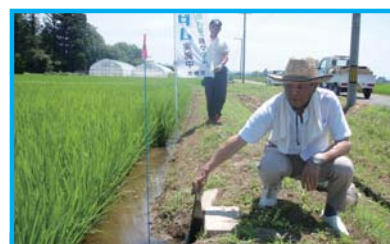
田んぼダム堰板設置 大崎市 中目地域環境保全推進協議会
