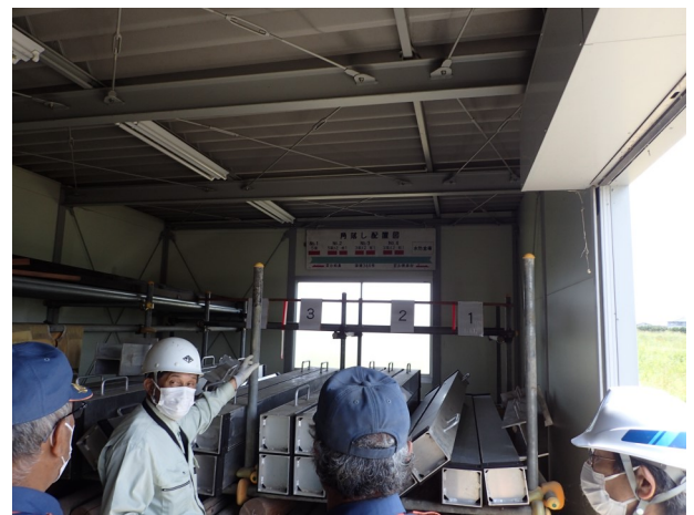
【資材保管状況の確認】
