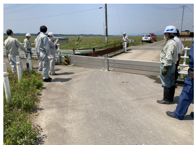
【陸閘の閉鎖確認状況】
