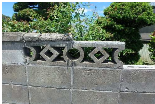
塀上部のすかしブロック、笠木がぐらついていないか
