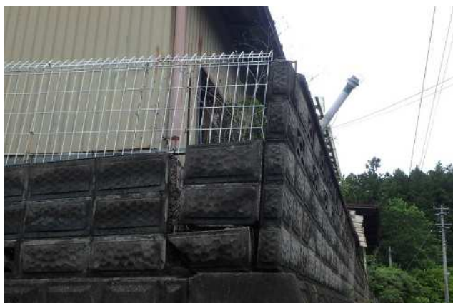
塀全体の傾斜がないか
