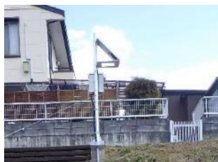
危機管理型水位計 (荒川・村田町)
