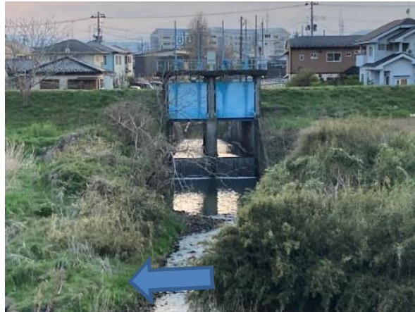
青川樋管 (大河原町)
