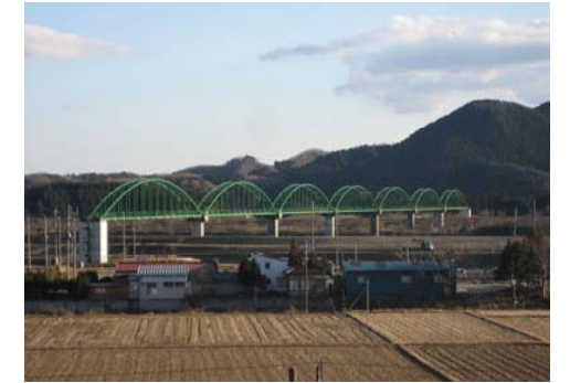
< 阿武隈川水管橋 >
