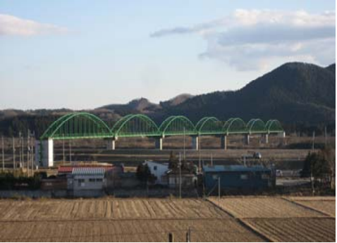
< 阿武隈川水管橋 >
